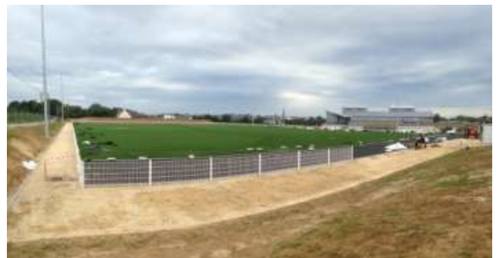
Mise en œuvre de la couche de souplesse et déploiement des lès de fibres synthétiques
